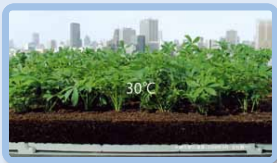
緑化編(スーパーソイレン工法)
