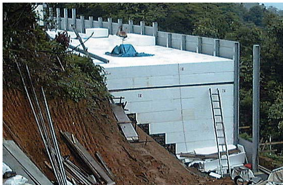
EPS土木工法 (道路拡幅盛土)
