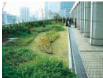
軽量緑化工法 (スーパーサイレン工法)
